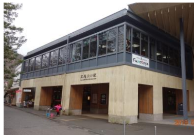
新築なった高尾山口駅舎
